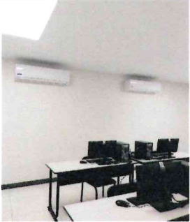
F7- MINI SPLIT CON CAPACIDAD DE 24000 BTU H - Sala de Computo
